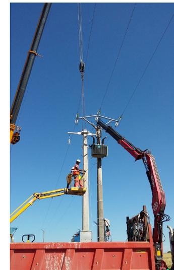
Coupure pour travaux réalisée à Vanault-les-Dames dans le cadre de la dépose du poste H61 (poste sur poteau) et mise en place d'un support d'arrêt.
