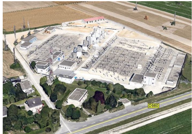
Le nouveau poste source « ORMES » (google EARTH)
