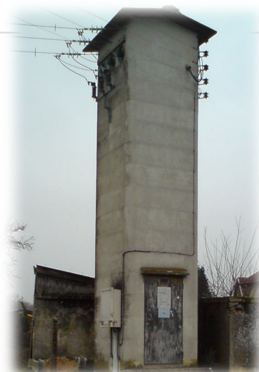
Poste de transformation de type cabine haute
